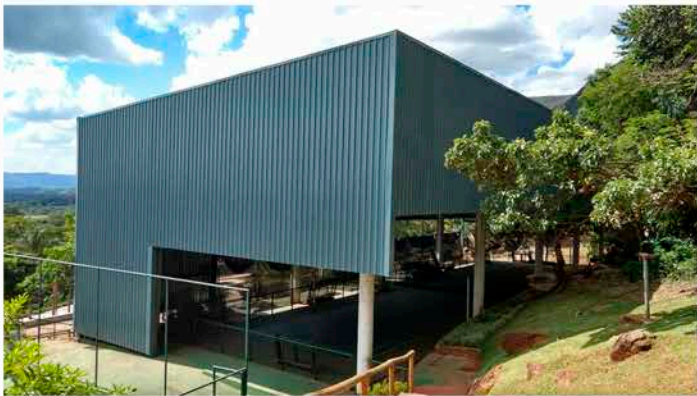
CONDOMÍNIO RETIRO DO CHALÉ - MONTAGEM DE ESTRUTURA METÁLICA, COBERTURA E TAPAMENTO LATERAL - 2016
