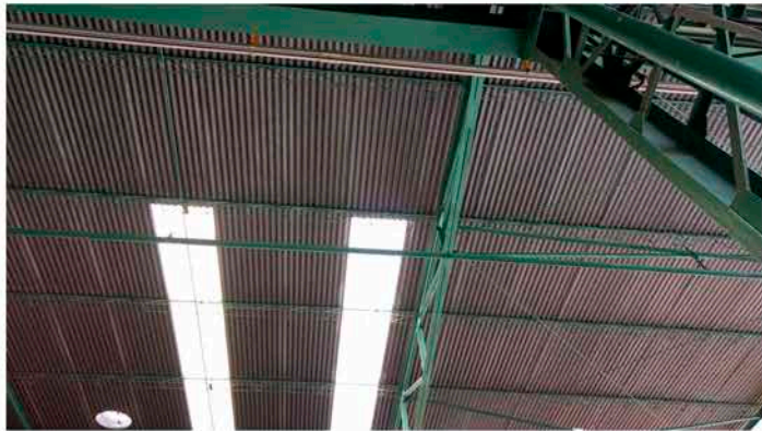
BHIP - MANUTENÇÃO DE COBERTURA - 2017
