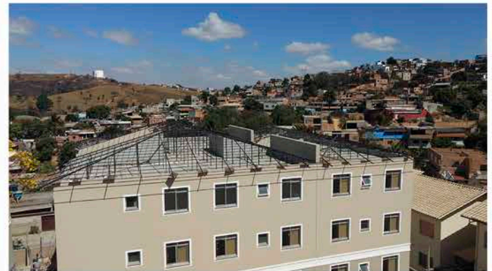
AP PONTO - MONTAGEM DE ENGRADAMENTO METÁLICO - 2017
