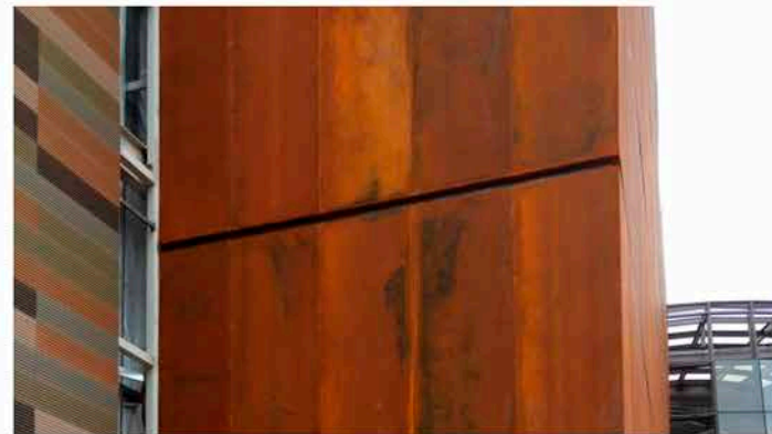
TOPUS CONSTRUÇÕES - MONTAGEM DE CHAPAS DE AÇO CORTEN - 2016/2017
