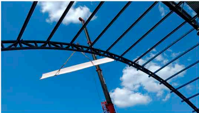
AZUL LINHAS AÉREAS - MONTAGEM DE ESTRUTURA METÁLICA E COBERTURA - 2017
