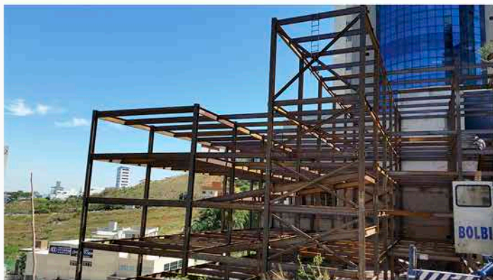
PÓRTO CONSTRUÇÕES METÁLICAS - MONTAGEM DE ESTRUTURA METÁLICA E STEEL DECKS - 2016
