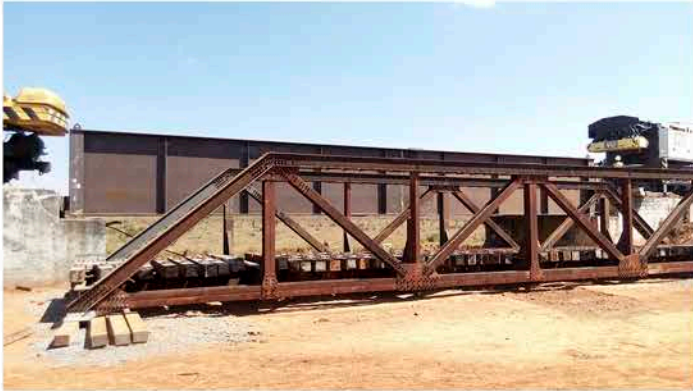
VLI - MONTAGEM DE PONTE METÁLICA - 2017
