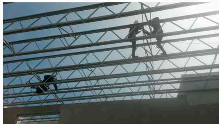
PERCAM - MONTAGEM DE COBERTURA ROLL-ON - 2016
