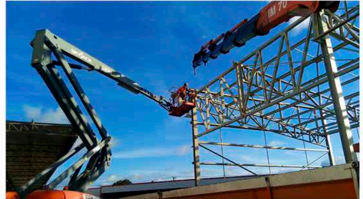
BELGO - MONTAGEM DE ESTRUTURA METÁLICA - 2017
