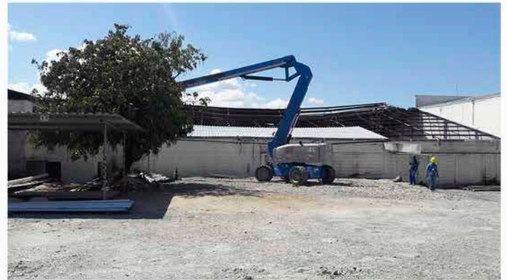
CONSTRUTORA BARBOSA MELLO - MONTAGEM DE ESTRUTURA METÁLICA E COBERTURA - 2016
